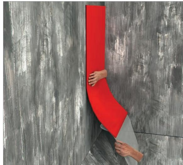
**5.** Den Vorgang 4 so lange wiederholen bis die Schutzfolie abgezogen ist und gleichmäßig an dem Grundkörper haftet.
